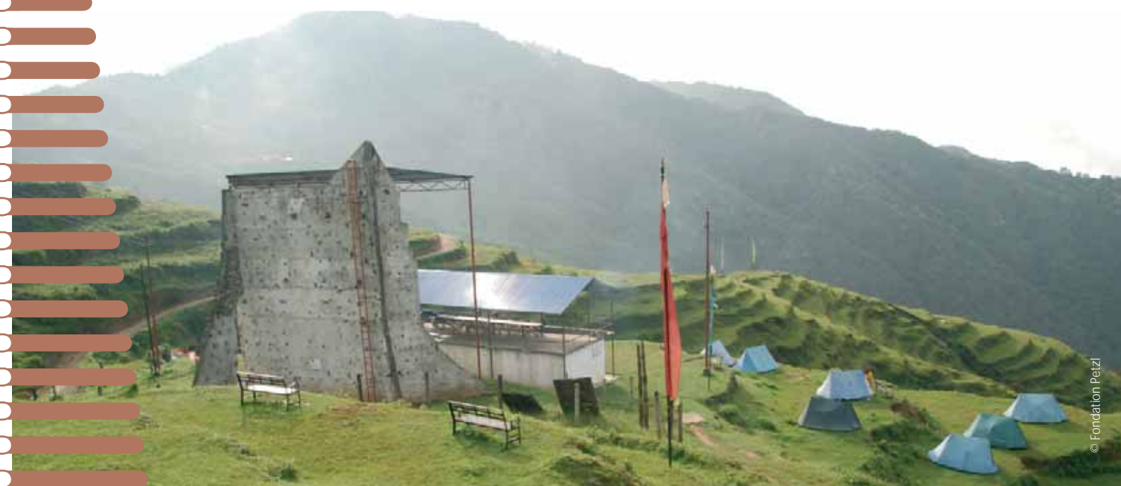
Le centre de formation à Kakani The training centre in Kakani
